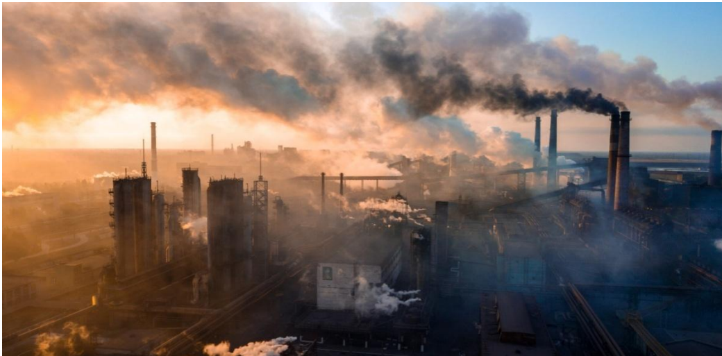
Figure 02 : Image montre la pollution de l'air (M.Morgan.al 2005)
