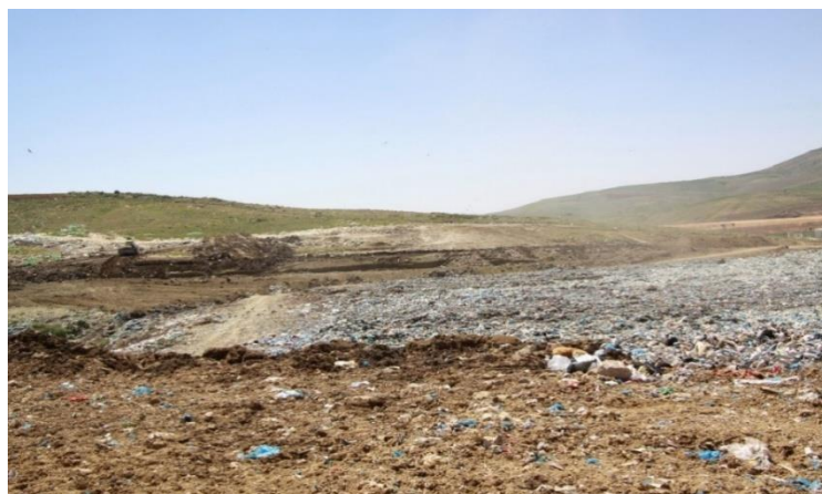
Photo(8) : Vue générale de l'espace extensible d'enfouissement ( Originale ).
