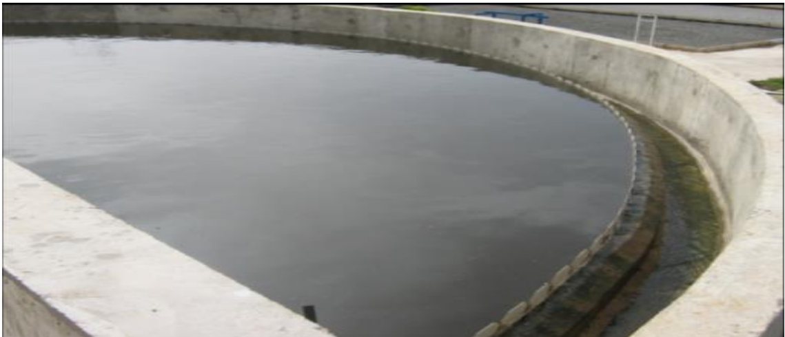
Figure 17 : forme des boues de station STEP de Saida (Photo : ONA, 2025)
