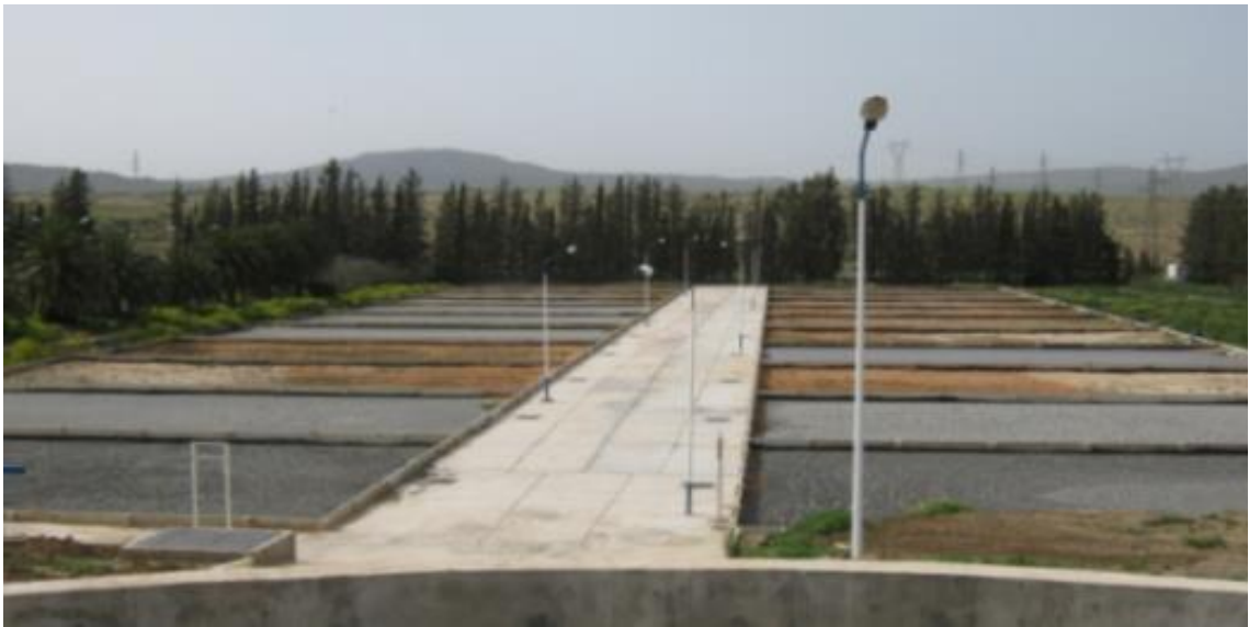
Figure 18 : Lits de séchage STEP de Saida (photo : ONA, 2025)
