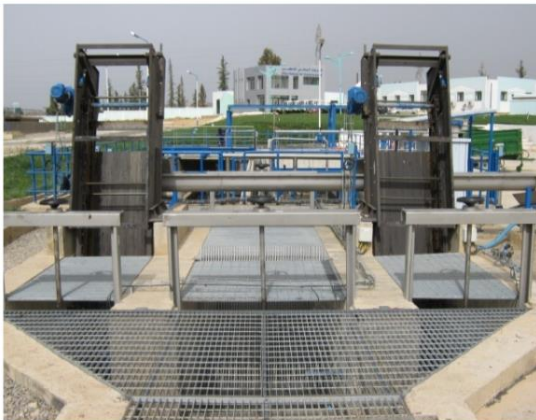
Figure 11 : unité de dégrillage STEP de Saida (Photo : ONA, 2025)
