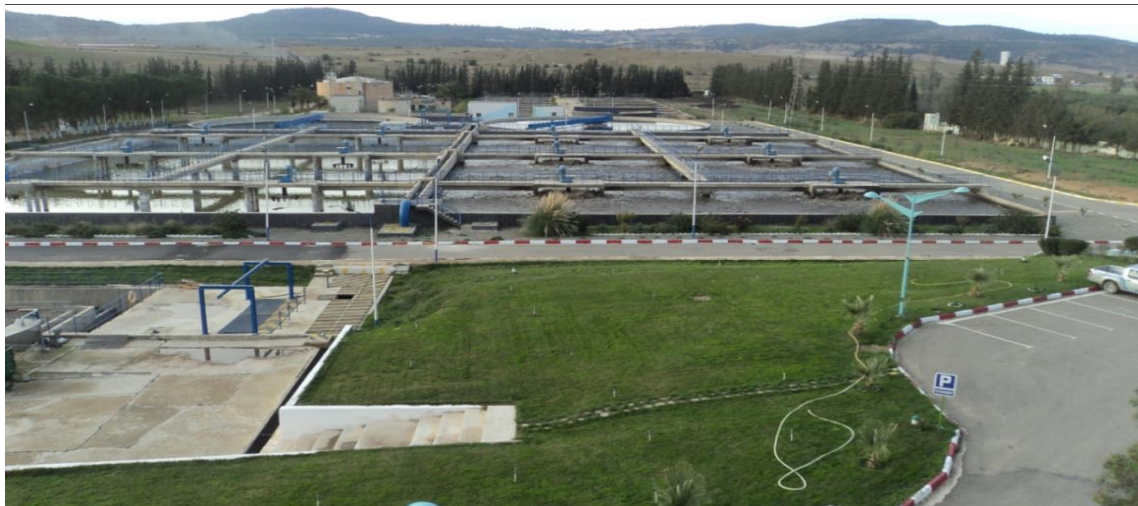
Figure 10 : vue globale de la station STEP de Saida (Photo : ONA, 2025)
