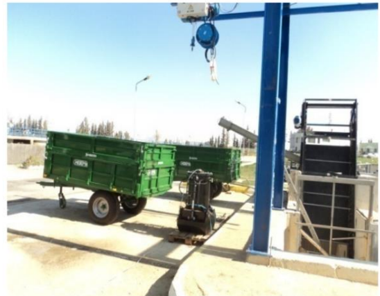
Figure 11 : unité de dégrillage STEP de Saida (Photo : ONA, 2025)
