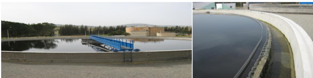
Figure 15 : Bassin de décantation STEP de Saida (Photo : ONA, 2025)
