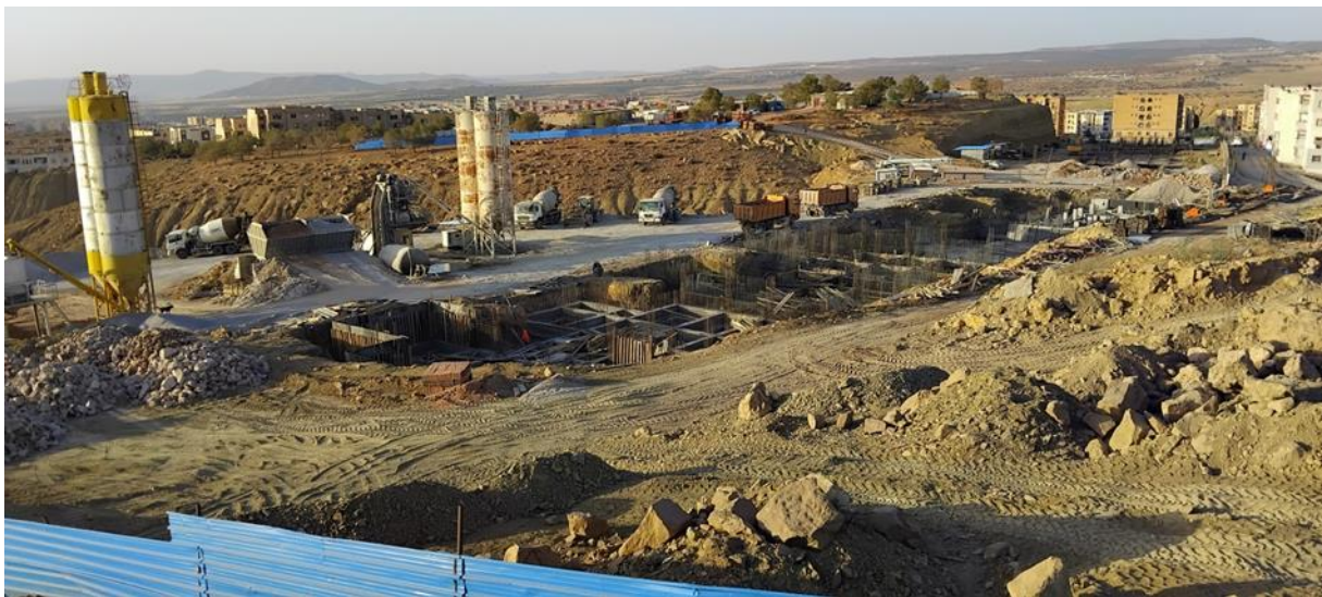
Figure 38 : travaux de construction de nouveaux complexes résidentiels par la face avant de forêt de Mkimen. (Amer et Brahimi, 2024, Photo du 05/06/2024)
