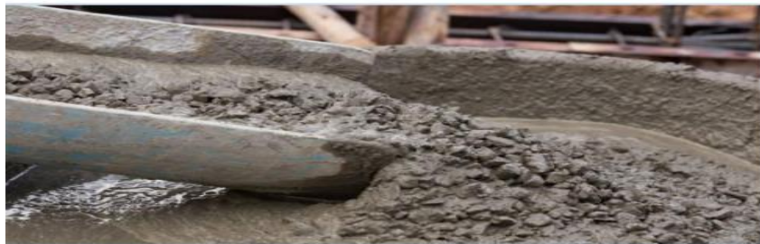
Figure I.2. Mélange du béton
