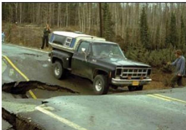
Figure 1.18 Tassement du sol compressible sous l'effet des charges apportées par le remblai [27]
