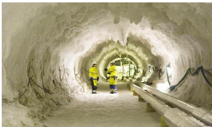
Figure 2.12 Travaux en souterrain : la congélation des sols [57]
