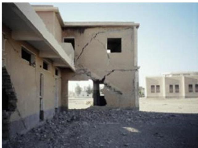
Figure 1.27 Bâtiments endommagés par les mouvements des sols argileux expansifs. Western desert, Egypt [41]
