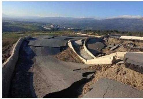
Figure 1.20 Zone touchée par un affaissement de terrain, commune d'Azazga (Tizi-Ouzou) [29]
