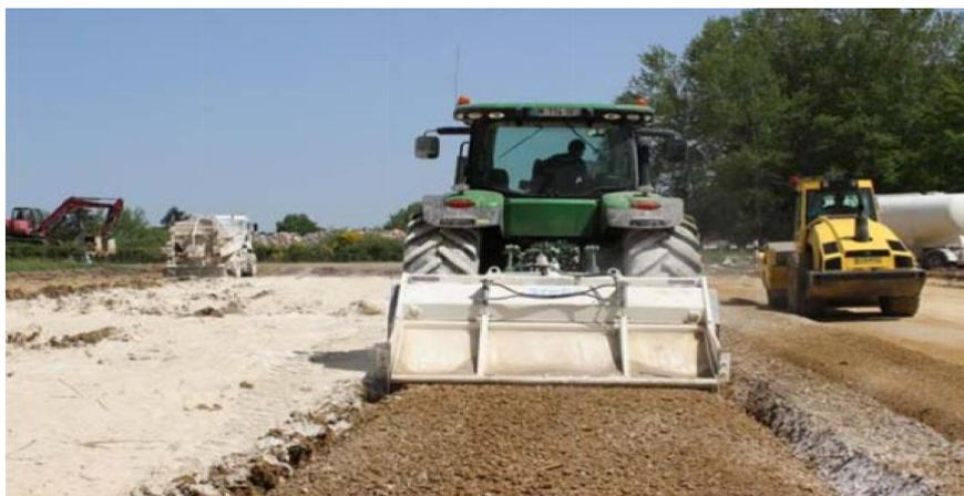
*Figure 2.14 Stabilisation des sols avec de la chaux ou du ciment [59]*
