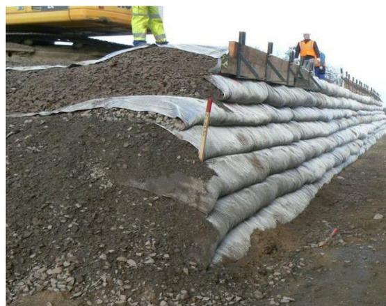
Figure 2.10 Renforcement par géosynthétiques [55]
