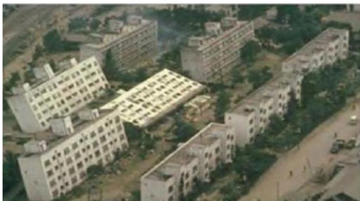
Figure 1.28 Liquéfaction du sol lors du séisme de 1964 à Niigata, au Japon [42]
