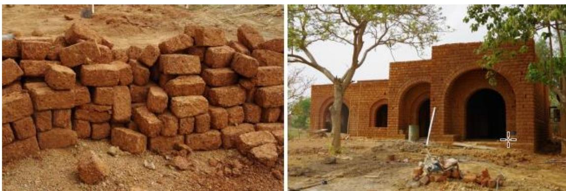
**Figure I.8: Blocs de terre et construction en Bloc de terre en Burkina Faso (Paulus, 2015)**
