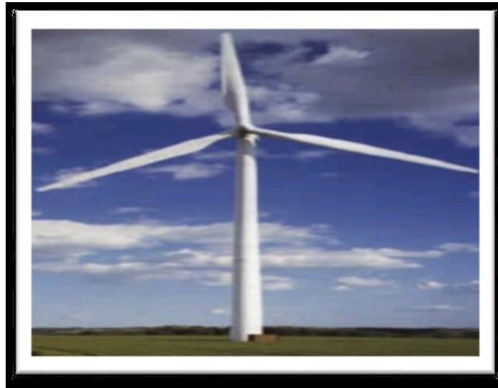
Figure I.4. : éolienne à axe horizontal.
