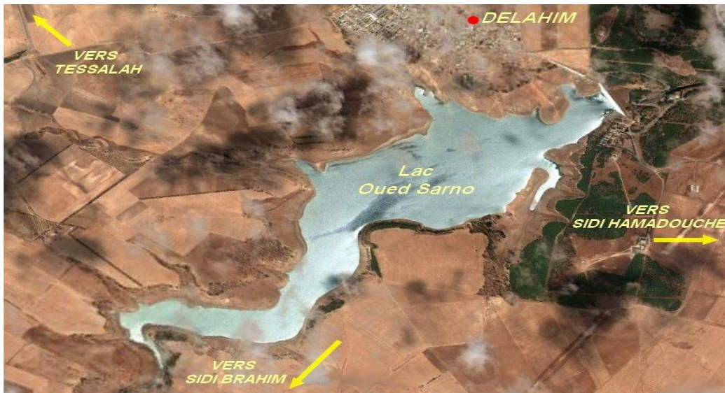
Figure 6: Localisation géographique du Barrage SANO (Wilaya de Sidi Bel Abbès) (ANAT, 2020) .
