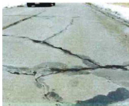
Figure II-16: Réseau de fissures de formes diverses. [23] Figure II-17 : Fissures en coin de dalle. [23]
