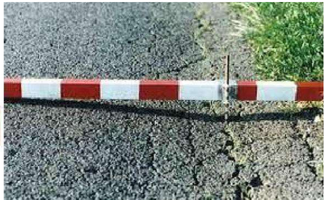
Figure II-1 : les affaissements. [20]
