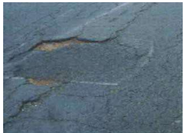
Figure II-13 : Réparation dégradée. [22]
