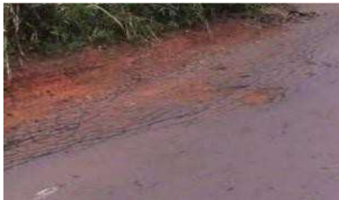
Figure II-18 : les épaufrures.
