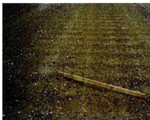
Figure II-22 : la tôle ondulée. [25]
