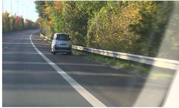
Figure I20 : La bande d'arrêt d'urgence (BAU)
