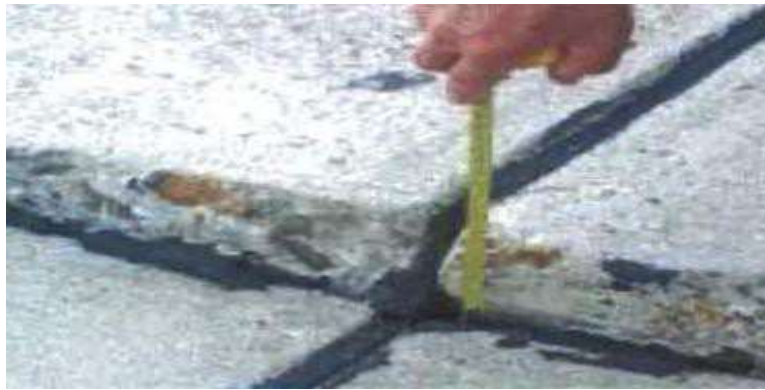
Figure II-19 : Exemple de décalage. [24]
