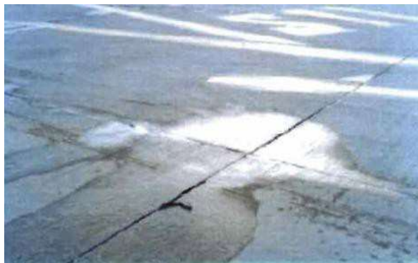
Figure II-20 : Pompage caractérisé par l'humidification de la chaussée aux bords des joints.
