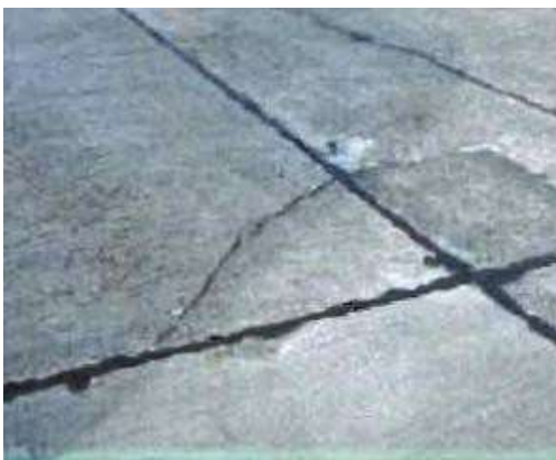
Figure II-16: Réseau de fissures de formes diverses. [23] Figure II-17 : Fissures en coin de dalle. [23]
