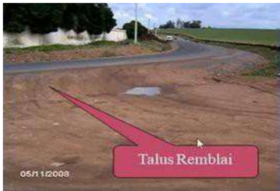
Figure I-17 : Talus en Remblai
