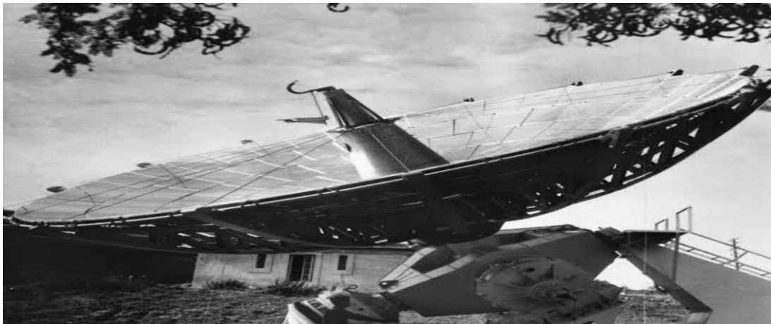
Figure I.8: Héliodyne le premier four solaire en Algérie [8].
