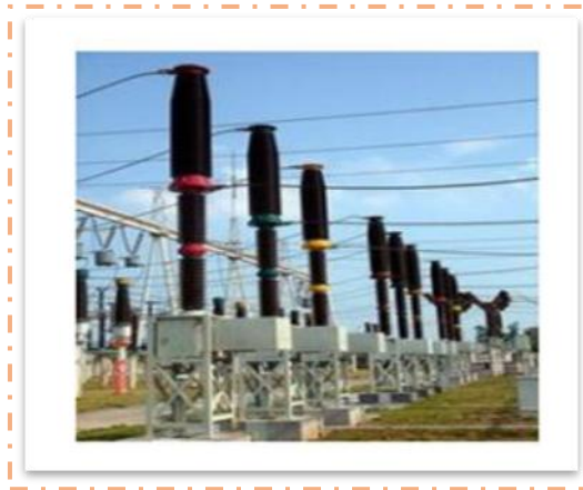
Figure (1. 6): Disjoncteur.
