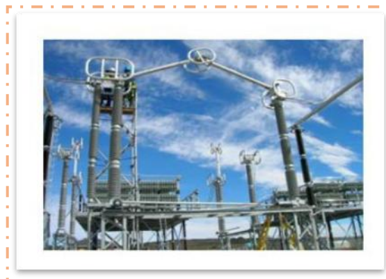
Figure (1. 7): Sectionneurs.
