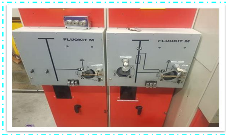
Figure (2. 11): Une mauvaise maintenance des cellules HTA.
