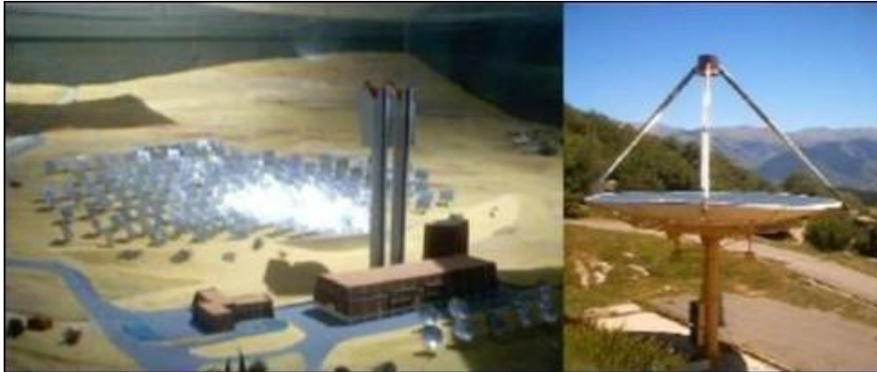
Figure II.4 : Champ d'héliostat - centrale solaire Thémis France.
