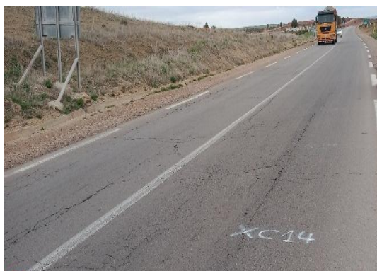
Carotte N°14 au PK 86+000 sur une fissure longitudinale.
