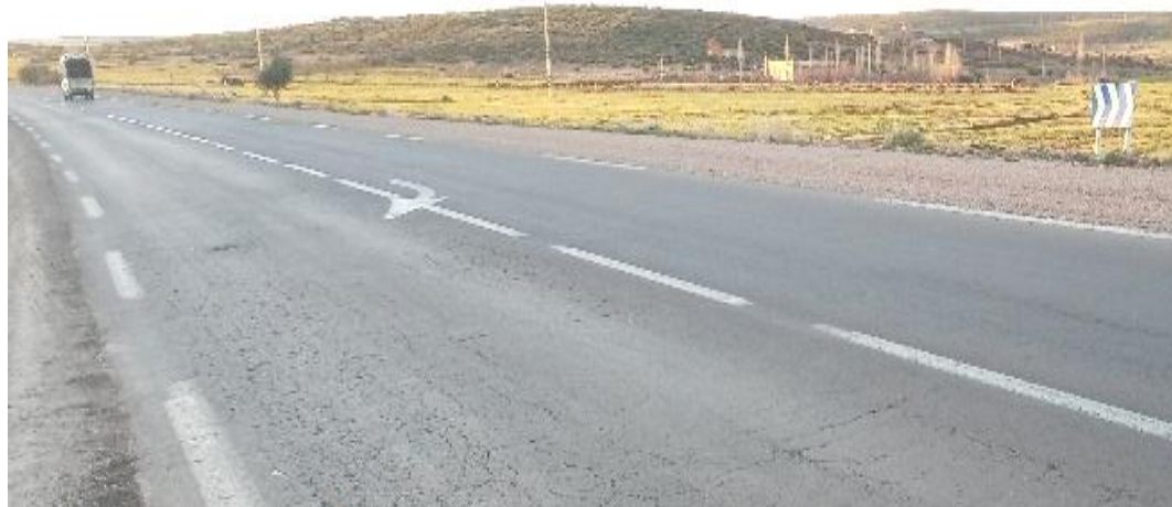
Figure III.13 : RN 94 PK 95+000 faïençage à maille fine
