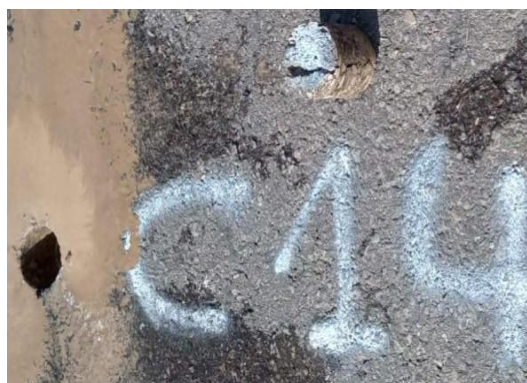
Carotte N°14 au PK 86+000 sur une fissure longitudinale.
