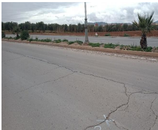
Carotte N°01 au PK 75+000 sur un faïençage à maille large sens vers Tiaret.
