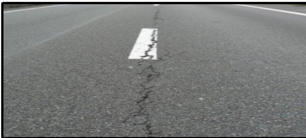
Figure II-6 : fissures Longitudinales [16]
