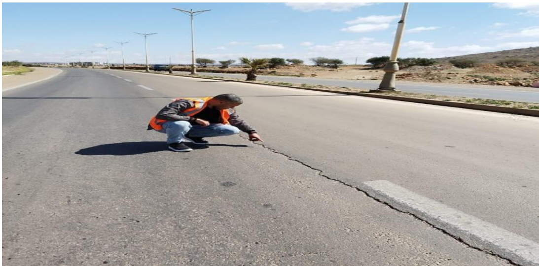
Figure III.9 : RN 94 PK 75+700 fissures longitudinales
