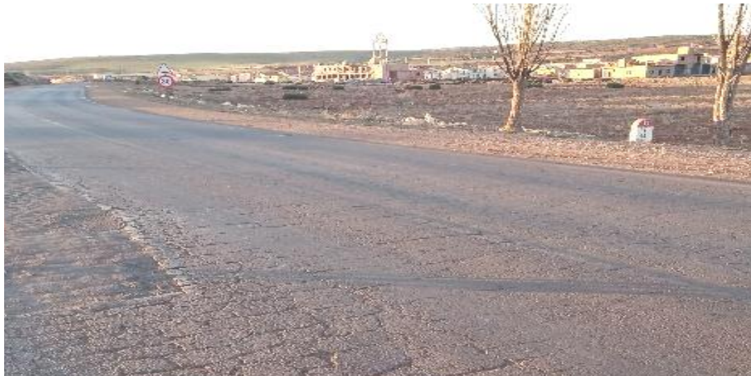
Figure III.12 : RN 94 PK 94+000 faïençage à maille fine
