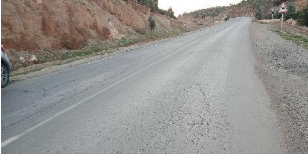
Figure III.14 : RN 94 PK 98+000 faïençage à maille large
