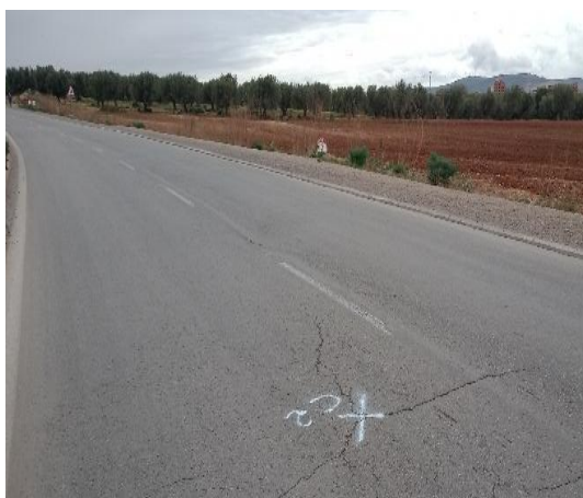
Carotte N°02 au PK 75+000 sur un faïençage à maille large sens vers Saïda.
