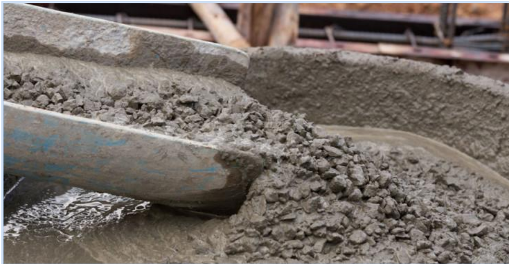
Figure III .I. 4 Mélange du béton.
