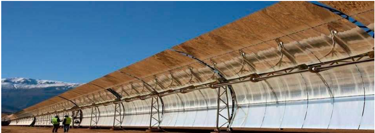
Figure I.2 : présentation du solaire à concentration thermodynamique producteur d'électricité [8]
