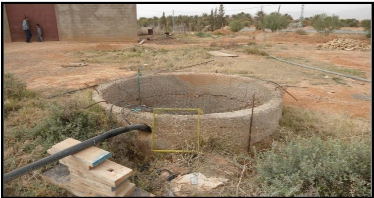
Figure 2: Puits maçonné de 2m de diamètre.
