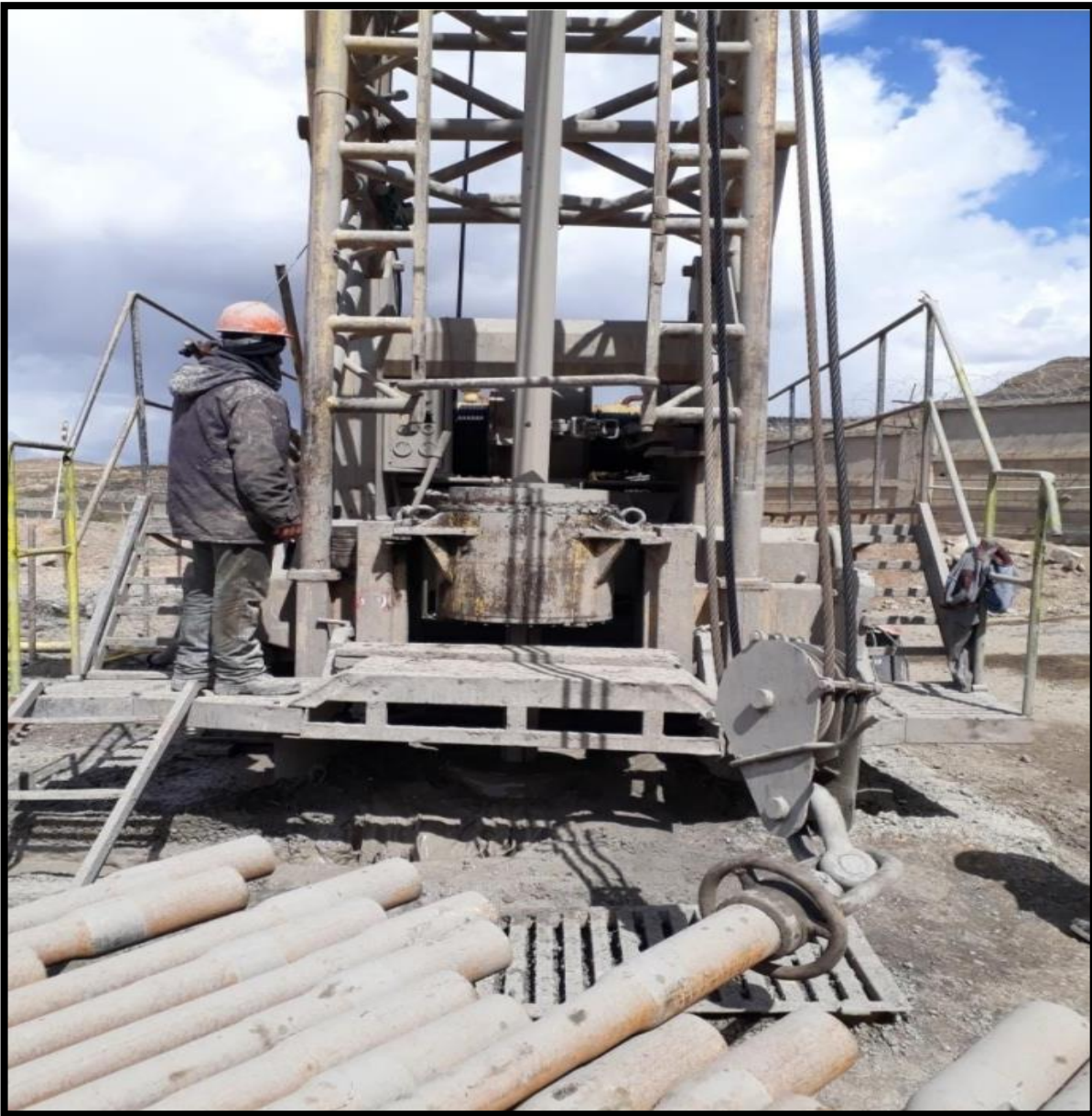
Figure 3: Un forage en cours de réalisation
