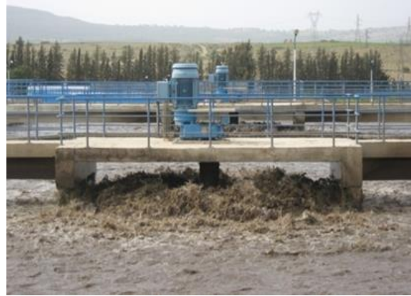
Figure I.9: Bassin d'aération
