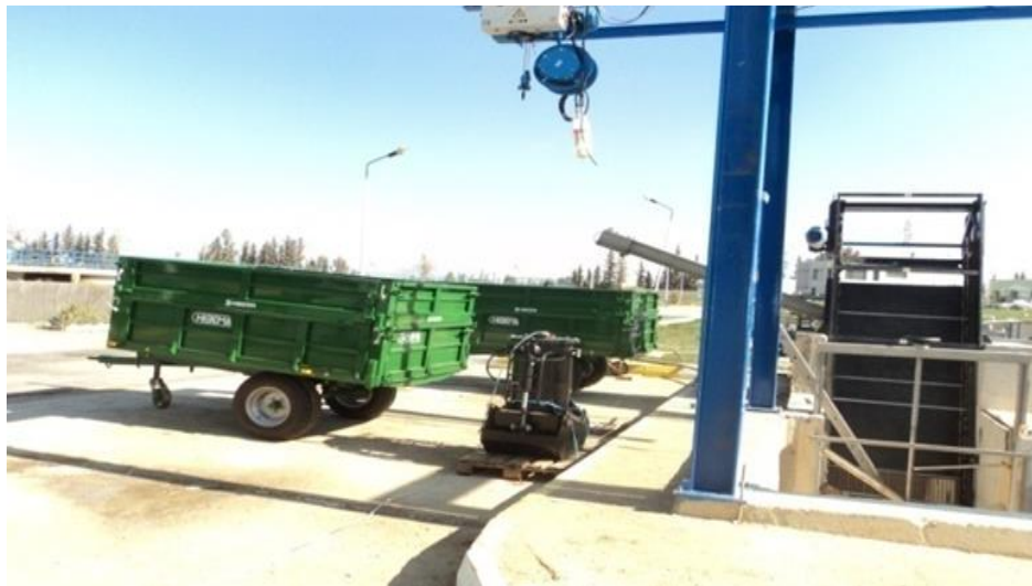
Figure I.7: Le dégrilleur
