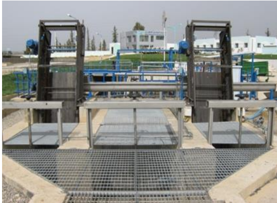
Figure I.3: dégrilleurs
