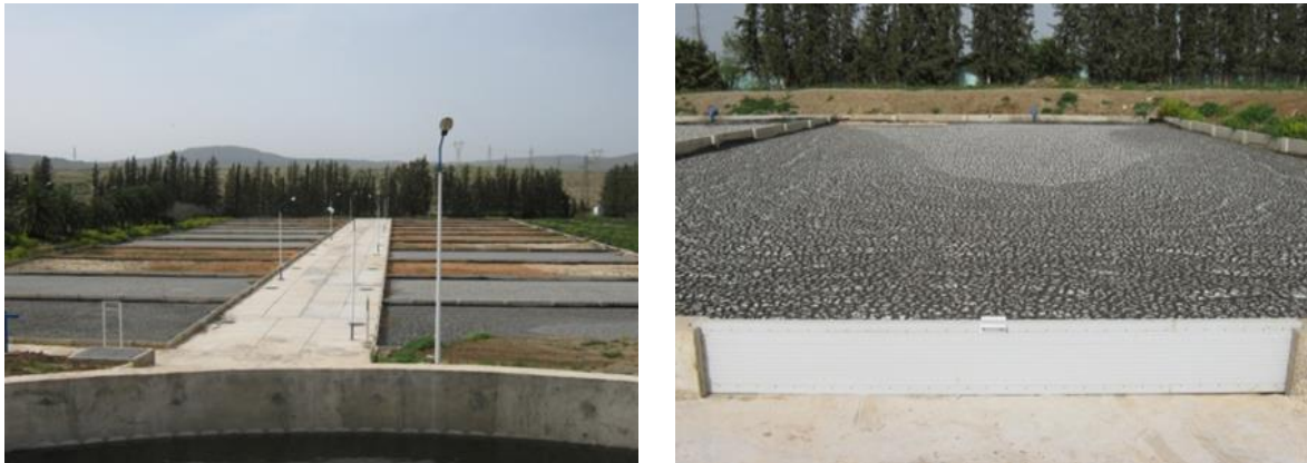
Figure I.13: séchage des boues
