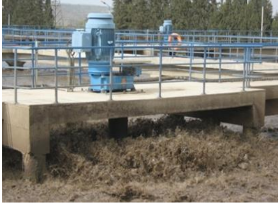
Figure I.9: Bassin d'aération
