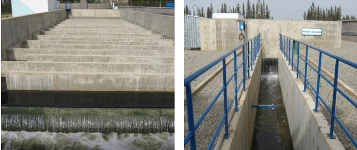
Figure I.11: L'opération de désinfection
