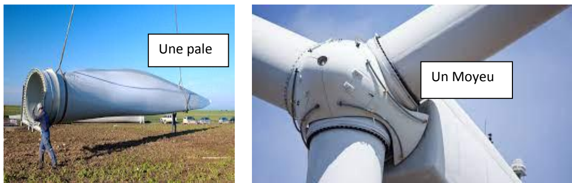
Figure I.36 : éléments constitutifs du rotor : pale et moyeu.
