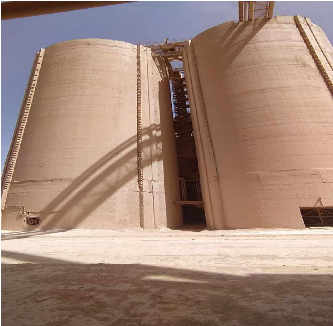
Figure 8: Silo de stockage et d'homogénéisation.
