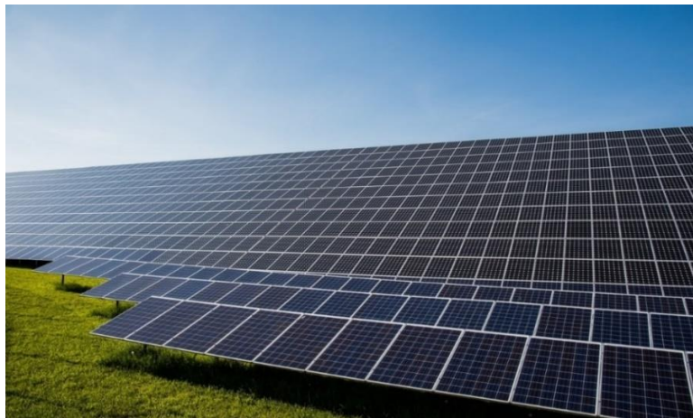
Figure I.1 : l'énergie Solaire photovoltaïque.
