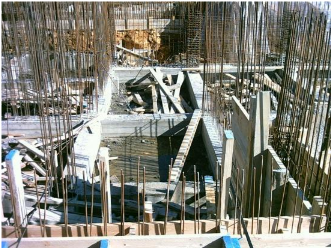
Figure VIII.3. Schéma d'un radier nervuré.
