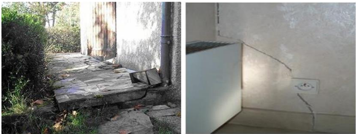
Figure o I- 13: Désordres de la structure au cours des périodes de sécheresse [19].
