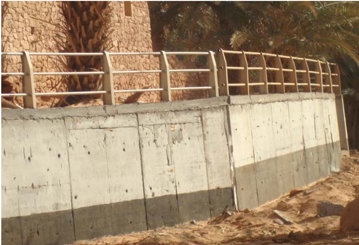
Figure V-1: Construction de mur de soutènement en béton autour du Q'sar de Boussemghoun
