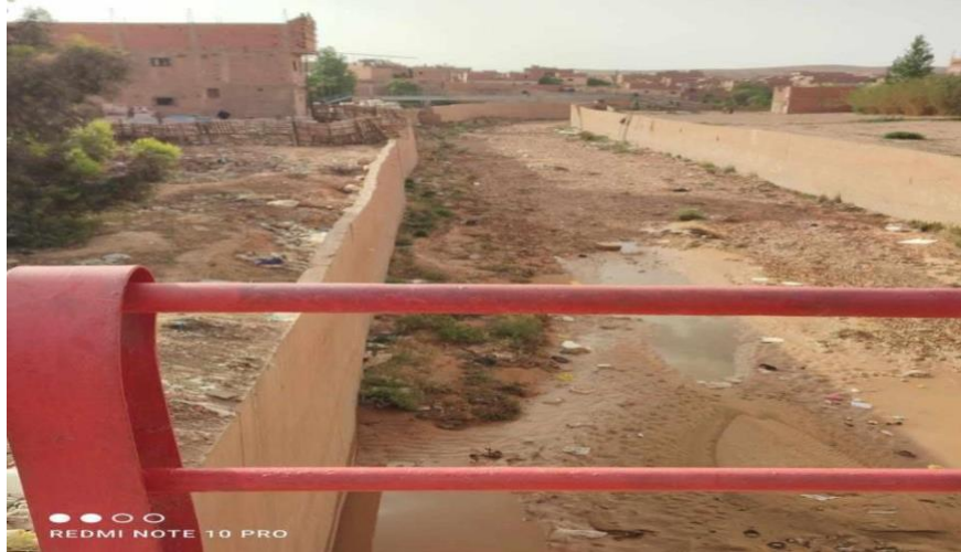
Figure 18 : Pont sur Oued Saffiet avec charriage
