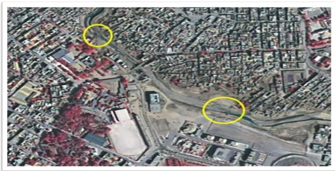
Figure 30: Impacts de l'inondation identifiés sur les images du satellite Kompsat (©KARI), matérialisés par la destruction de deux passerelles (cercle en jaune). Chabane et Labbaoui (2016)
