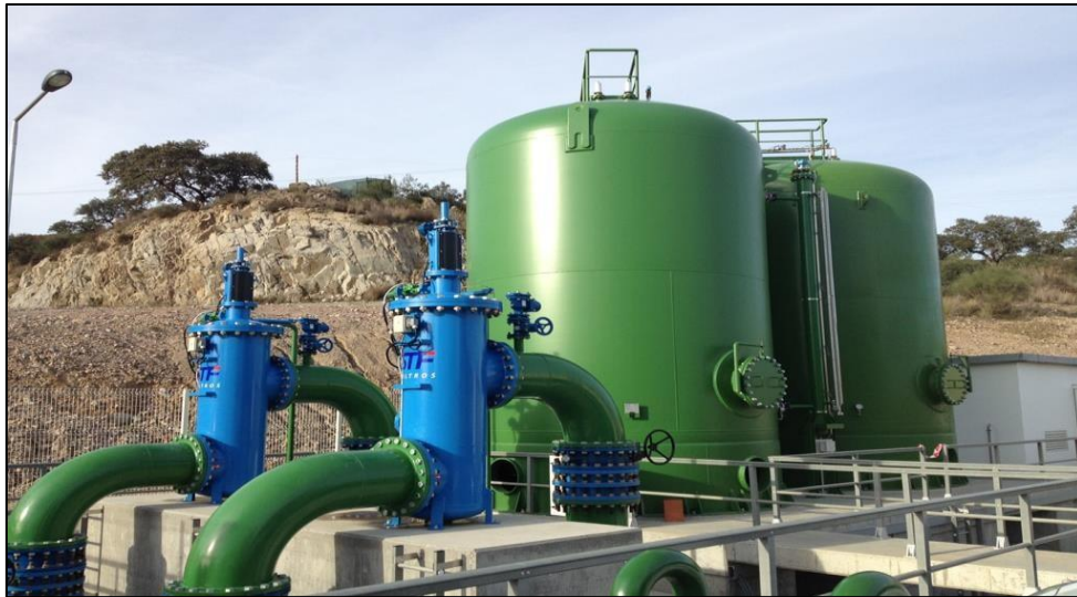
Fig 6.01 : Réservoirs d'air
