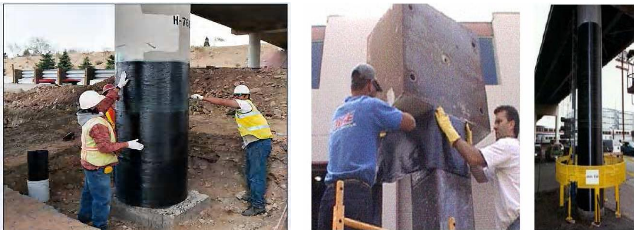
Fig. II .7: Confinement des colonnes
