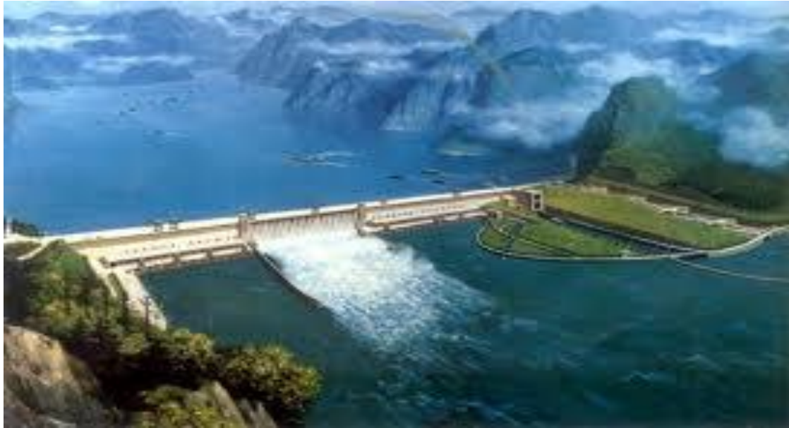
Fig. I.1 Barrage poids (Barrage des Trois Gorges CHINE).
