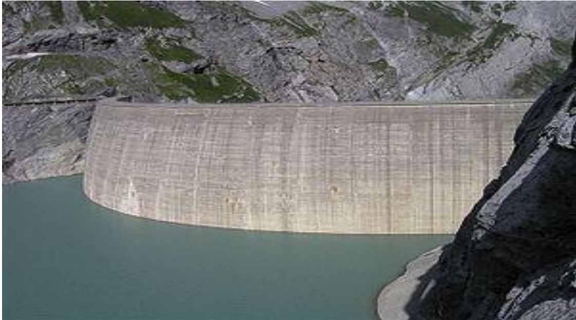
Fig. I.2 Barrage voûte (Barrage Limmern en Suisse).
