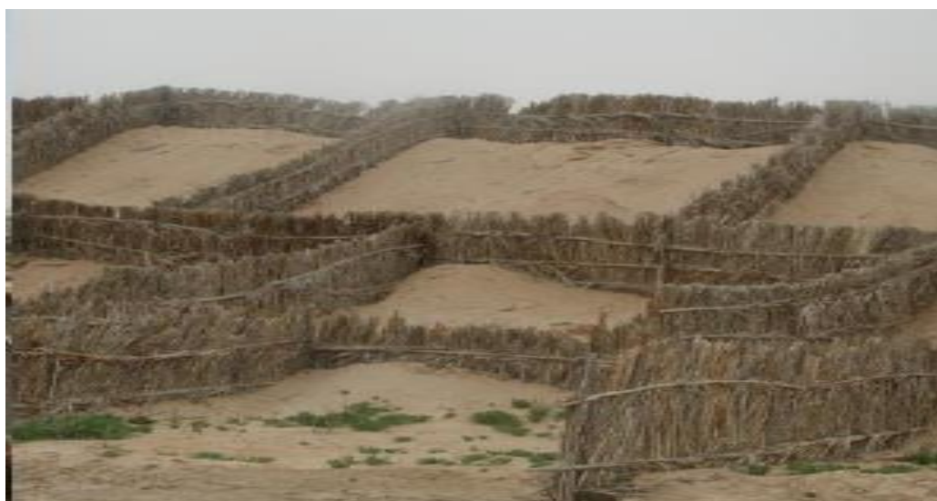
Figure 38 : Palissades pour fixation de dunes au Niger.
