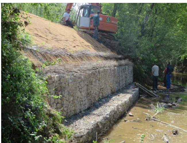
Figure 49 : Le gabion surmonté végétalisé Source : lacompagniedesforestiers.com
