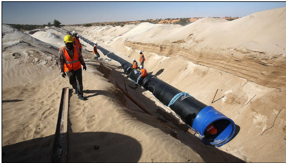
Figure 1: Pose de conduite en tranchée
