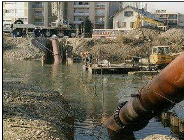
Figure 5: Pose dans le lit d'une rivière
