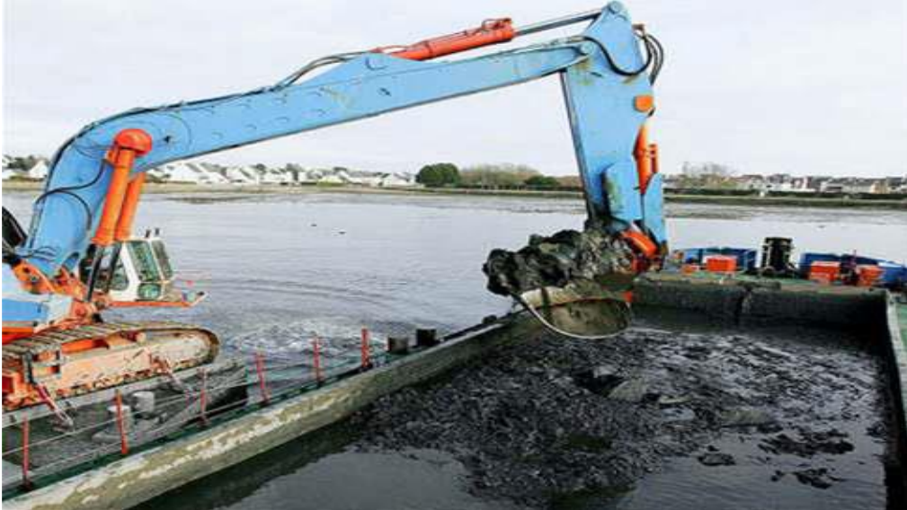
Photo 1 : Dragage mécanique. [2]
