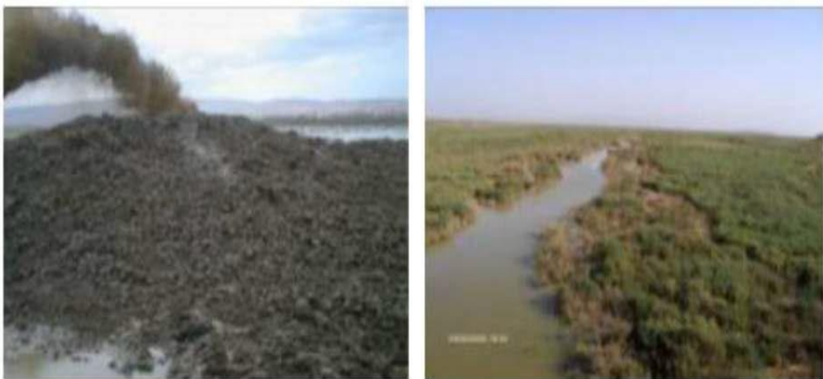
Photo 3 : Rejet de la vase draguée (Barrage de Fergoug). [3]
