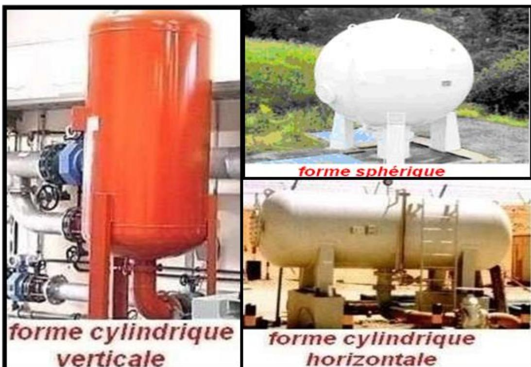
Figure N°25 : Les différentes formes de l'anti-bélier (réservoir d'air).
