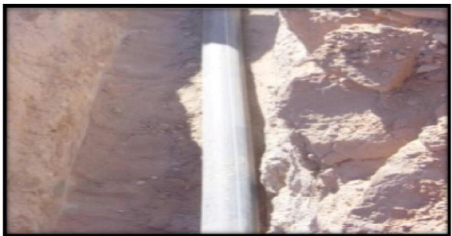
Figure N°29: Pose des conduites en terre
