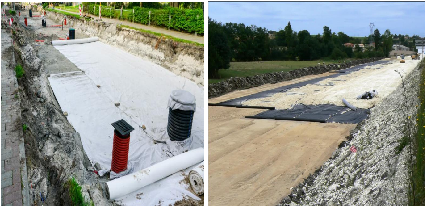
Photo 3: Stabilisation des pentes par géosynthétiques - Naue - Géosynthétique - Logiciel d'ingénierie numérique
