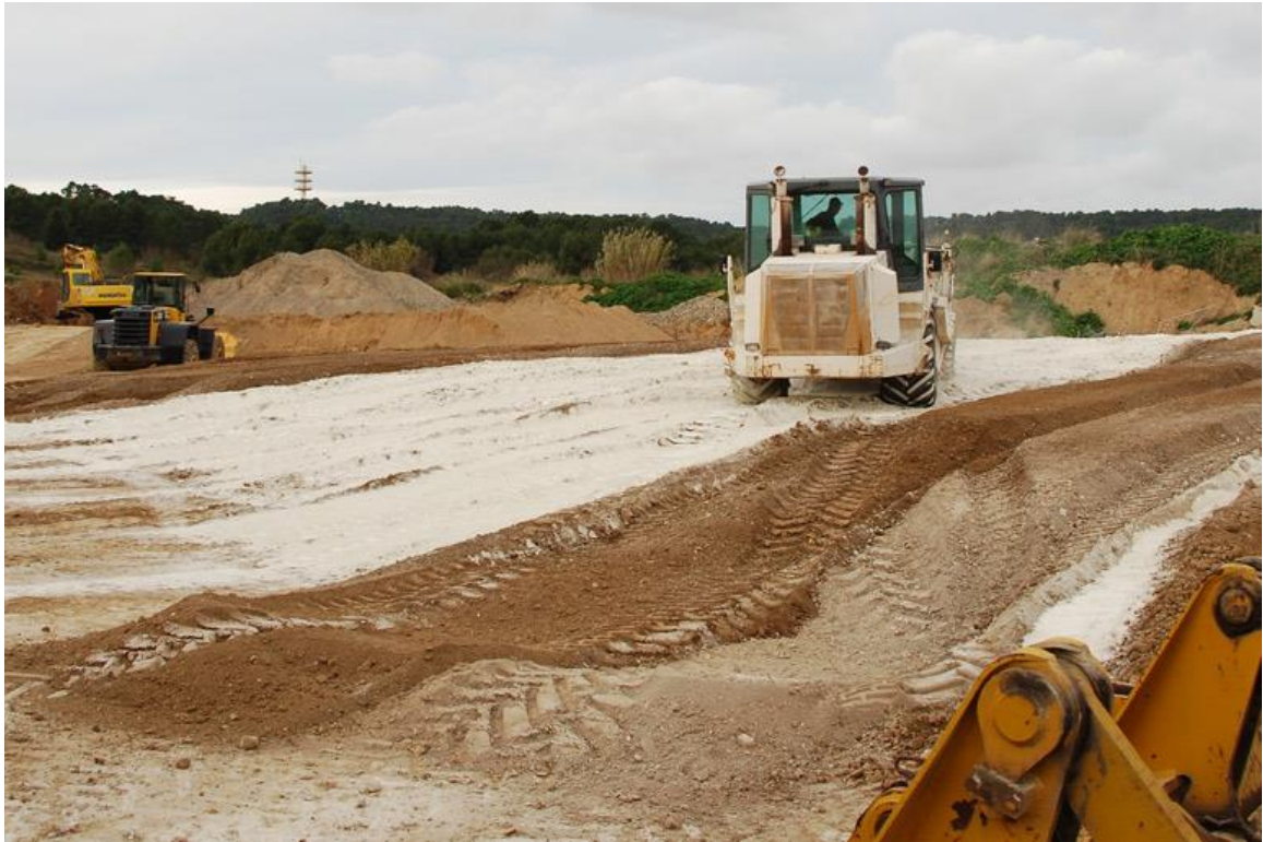
Photo 1: Traitement de sol à la chaux – GTR
