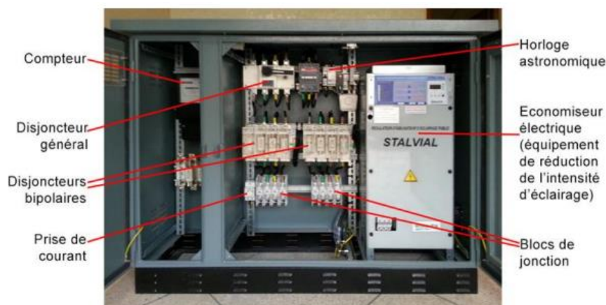
Figure 2.23 : Les composants principaux de l'armoire d'éclairage public
