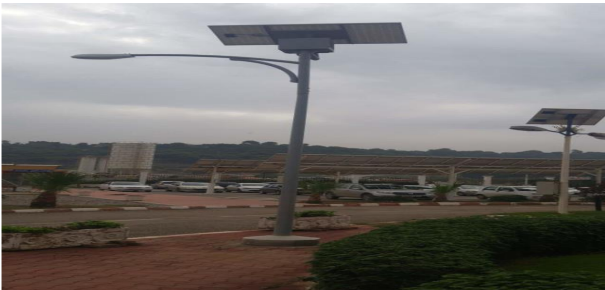
Figure 3.5 : Candélabre solaire à LED réalisé à l'UDES/ CDER- Centre de Développement des Energies Renouvelable-
