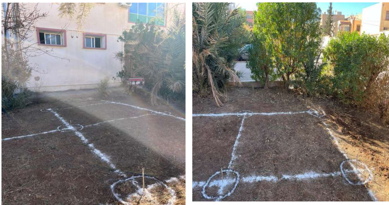
Figure 47: Le traçage avec le plâtre (cliché Saidani 2024)
