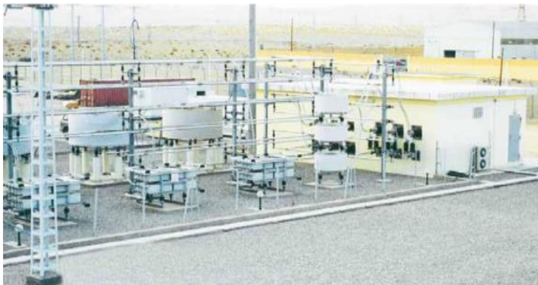
Figure(II.2): Photo montrant l'une des Plates-formes des trois SVC en l'Algérie.
