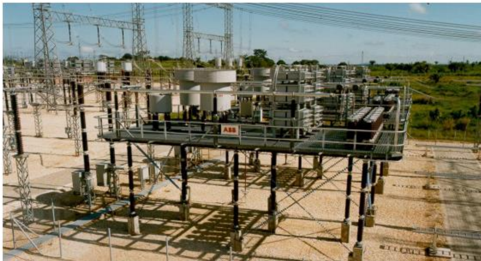
Figure(II.9) : Exemple réel du TCSC.
