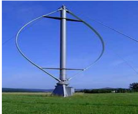
Figure I.5: Eolienne à axe vertical de type Darrieus.
