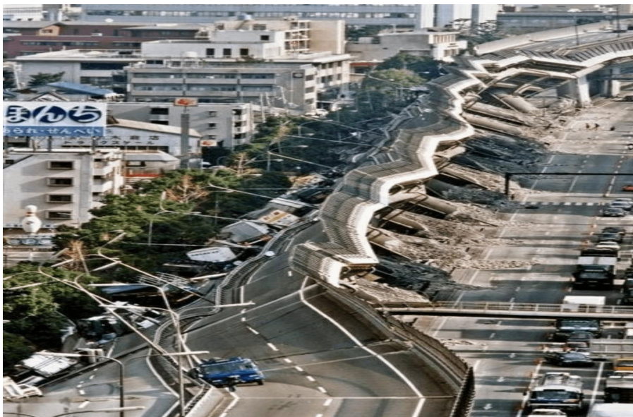
Figure I-1 Les conséquences du tremblement de terre à kobe
