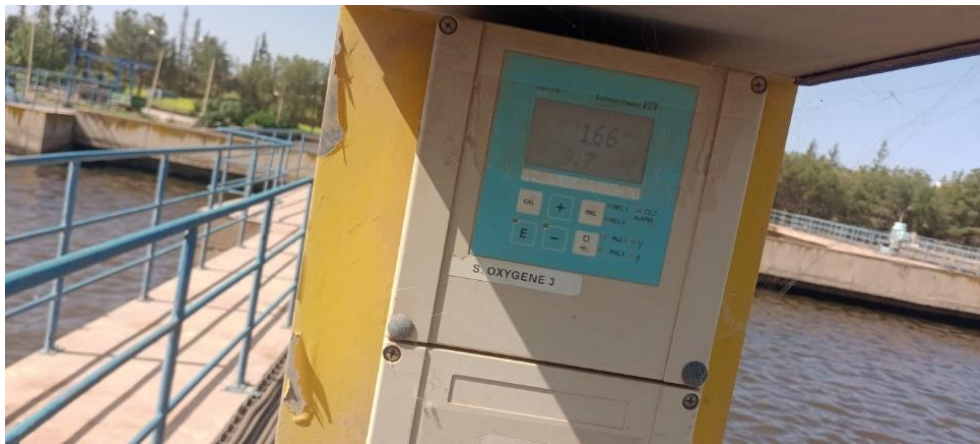
Figure III.5 : Oxymètre du bassin biologique
