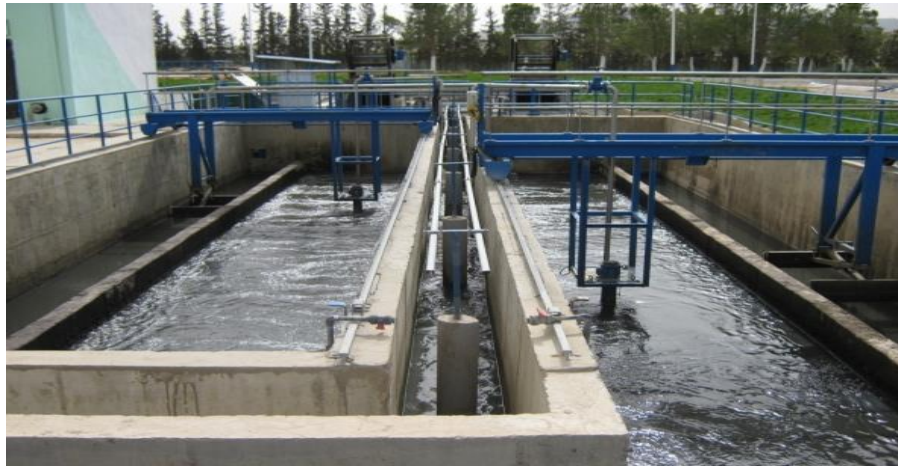
Figure II.8 : Dessablage –Déshuilage
