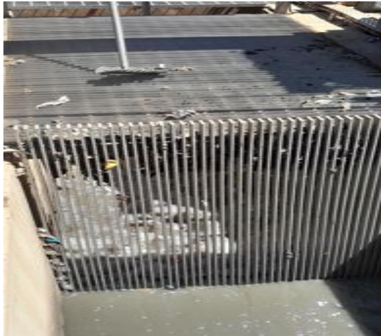
Figure II.7 : Dégrillage.
