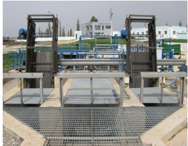
Figure II.7 : Dégrillage.
