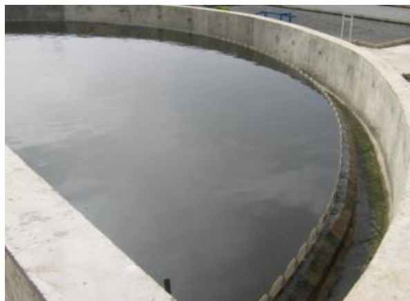
Figure II.12: Epaississement des boues
