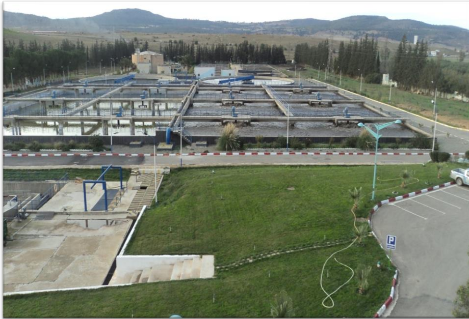
Figure II.14 : Vue globale de la Station d'épuration de la ville de Saida.
