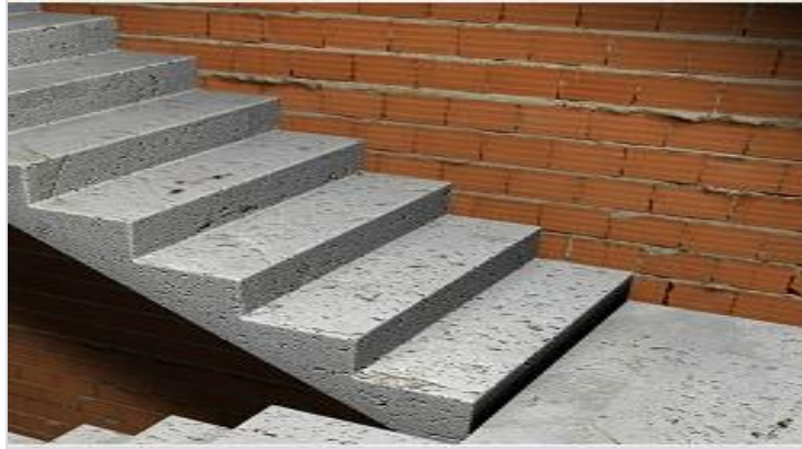
Figure IV.4: Escalier en béton armé.
