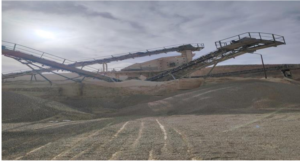
Figure II-4 : Photo n°01 concasseur de la carrière SARL O. OUALI de sidi boubker
