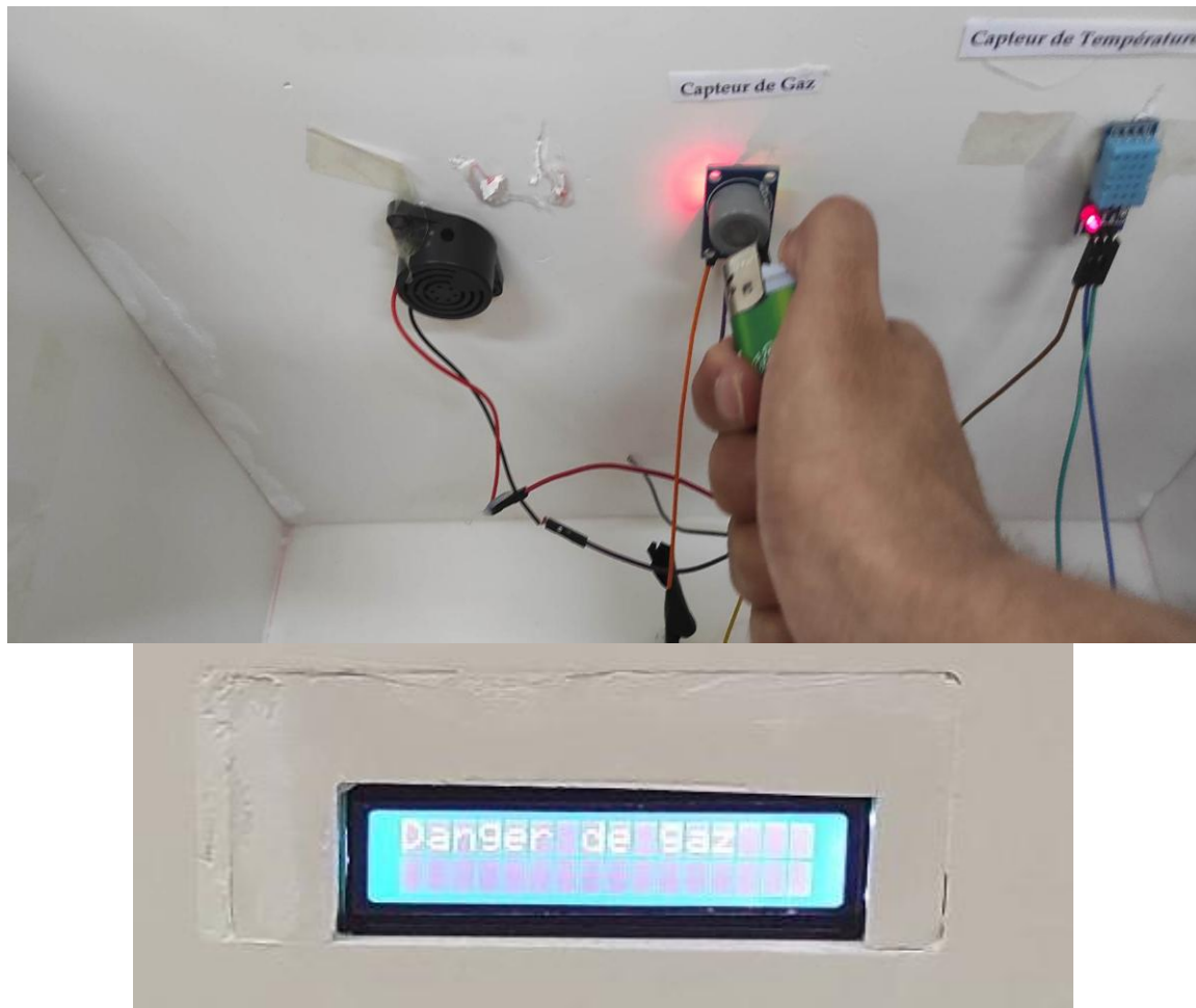
Figure 3.16 : Photo réelle de notre système intelligent qui détecte la fuite de gaz.
