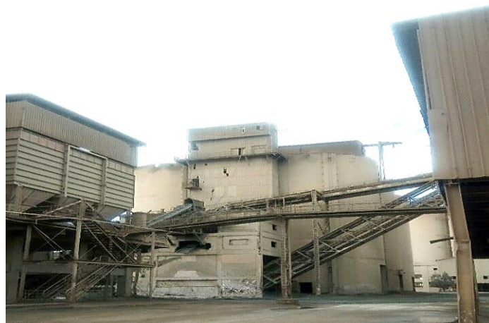
Figure I.7 : Silo de Stockage du clinker de la cimenterie Saida.
