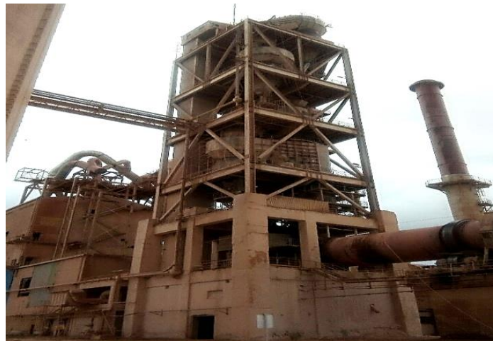
Figure I.5: Tour de préchauffage de la cimenterie de Saida.
