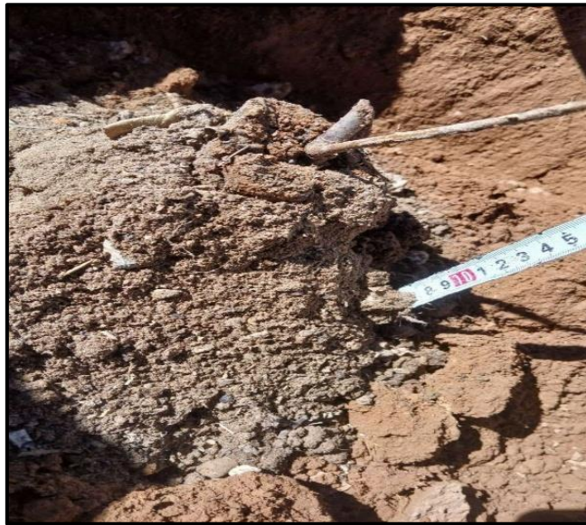
Figure 25: Recouvrement des racines par une couche de sol d'environ 10cm. (Boutalbi, Dahmani, 2026).
