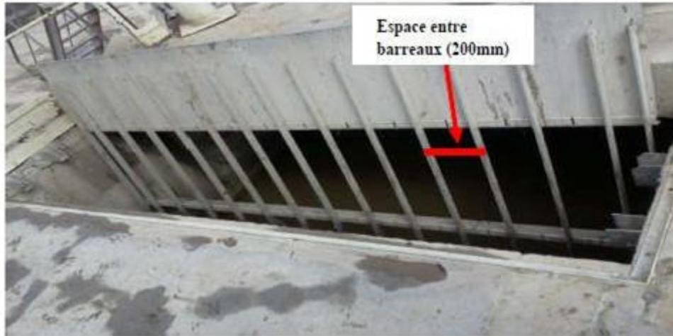
**Figure 1.** le prédégrilleur à l'entrée de la STEP
