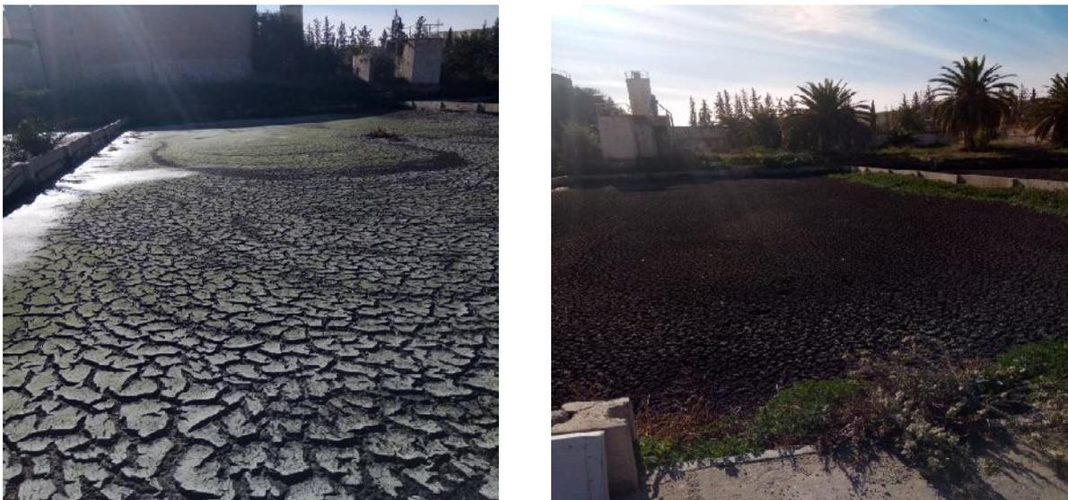
**Figure 8 .** Déshydratation des boues sur lits de séchage
